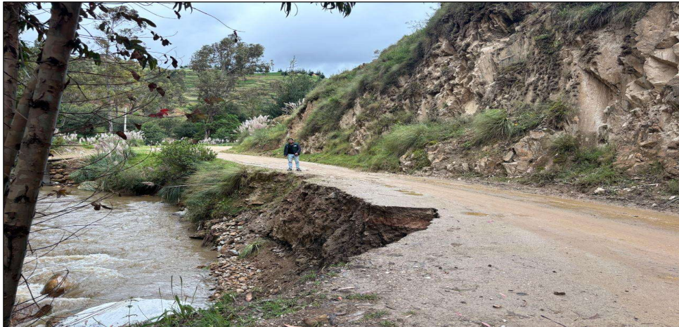
Figura N° 01. Muestra el avance de la erosión en la margen izquierda del río Tranca, donde el agua ha socavado la plataforma de la carretera afirmada que conecta los C.P. Porvenir y Libertad con el distrito de Llata, poniendo en riesgo la vía y la seguridad de los transeúntes.
