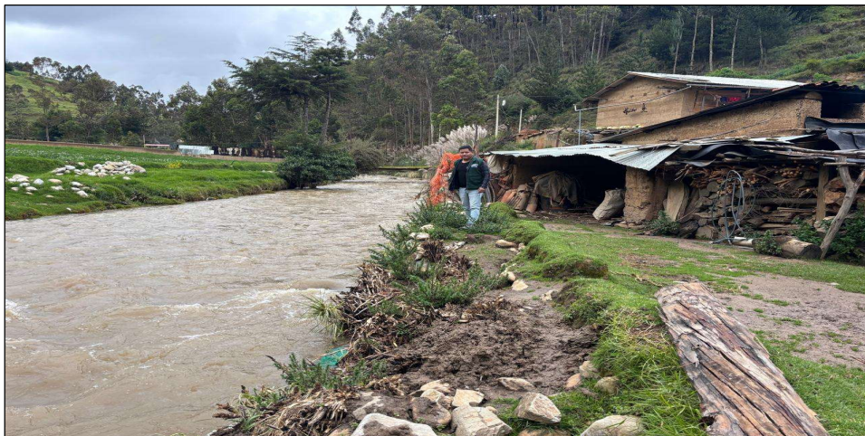
Figura N° 02. Muestra el desborde del río Tranca afectando viviendas cercanas. La erosión ha debilitado el terreno, poniendo en riesgo las estructuras y la seguridad de los habitantes.
